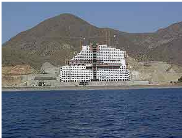
Imagen del hotel que se construía en la playa del Algarrobico. (Foto: G. Catalán)
